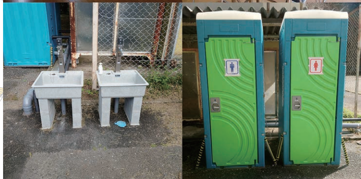
洋式の水洗トイレ、水道も完備されています。
